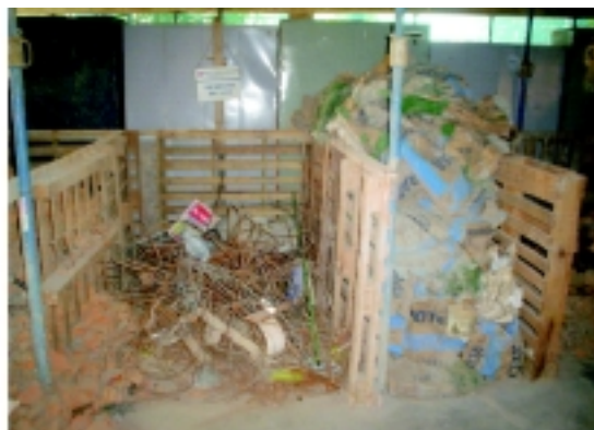
Figura 29 - Local para armazenamento de resíduos segregados no canteiro de obra.
