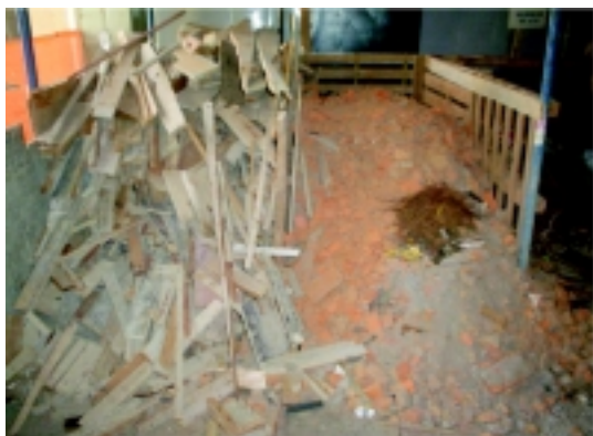
Figura 29 - Local para armazenamento de resíduos segregados no canteiro de obra.
