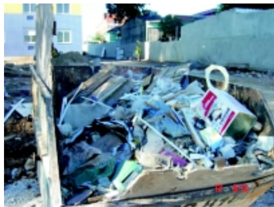
Figura 26 - Caçamba com entulho de obra
