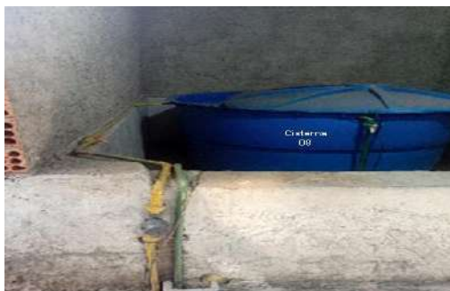
Figura 3.7– Cisterna Água Filtrada ETE
